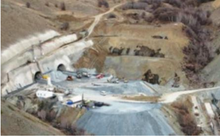
Şekil 5. Kop Tüneli, Erzurum-Bayburt Arası
